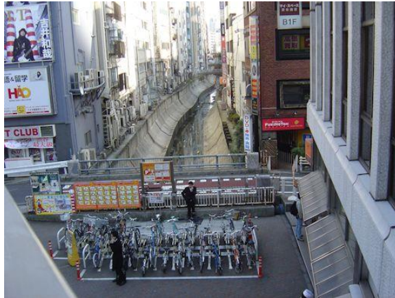
ここから先は暗渠になって北上する渋谷川（渋谷駅付近）
