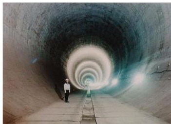
神田川・環状七号線地下調節池
