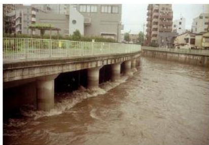
神田川取水施設取水状況
