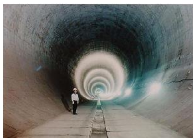
神田川・環状七号線地下調節池
