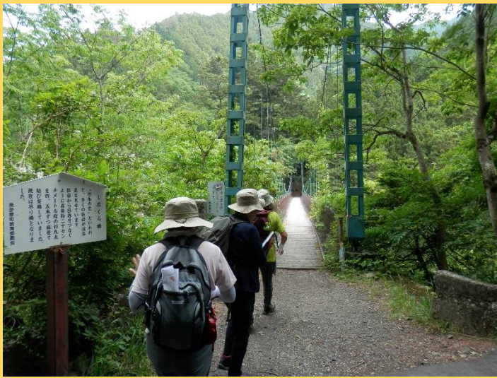
多摩川に架かる定員3人の「しだくら吊橋」
