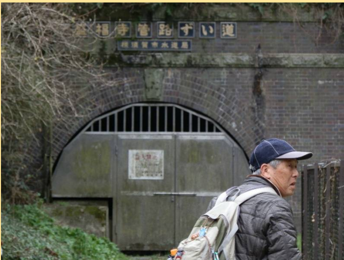
盛福寺管路すい道は閉鎖。え〜、通れないの？
