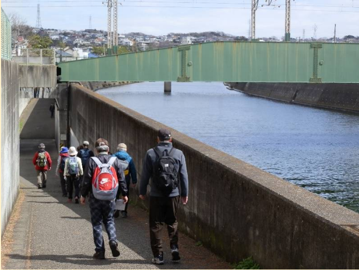
遊歩道はここで江ノ電境川橋梁の下を潜ります。
