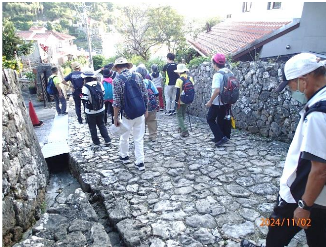
急な石畳を慎重に下る。琉球石灰岩が敷かれている。石灰岩の表面は浸食され、凸凹していてなかなか手ごわかった。
