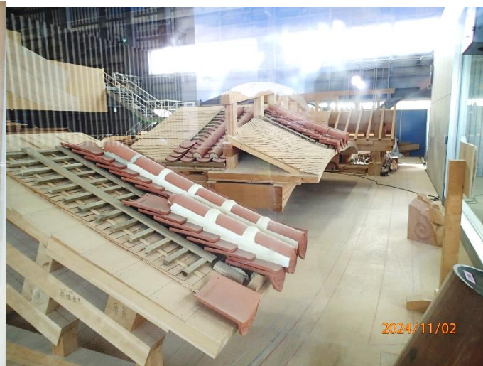
正殿の建て方説明がされている所を見学。屋根瓦の取り付け方の説明展示。瓦の隙間からの雨の侵入を防ぐために瓦の継ぎ目は漆喰で固めてあった。
