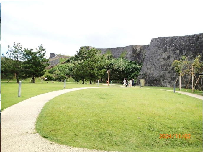
城壁はなだらかな曲線で本土の城の角ばった石垣とは違って。これは沖縄のどこの城(グスク)でも見られた。
