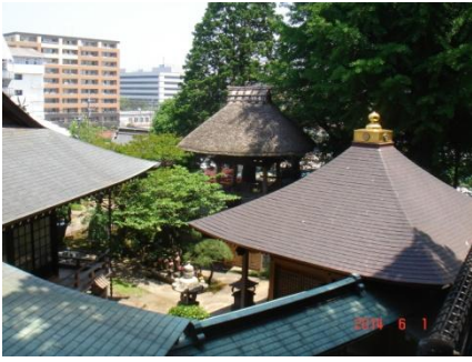
裏山から見る
