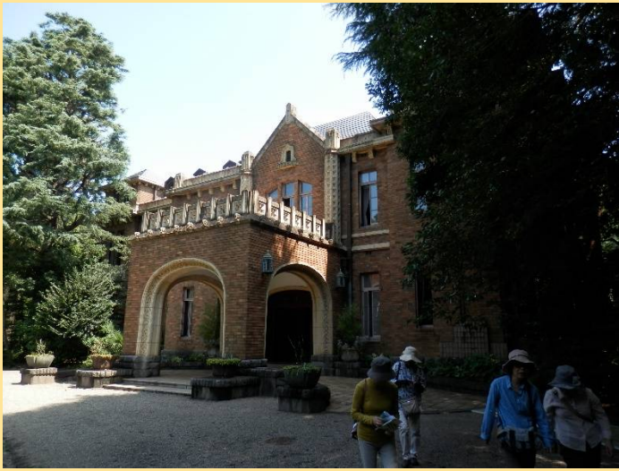
外観はまさに森の中の洋館。
